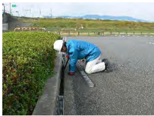
駐車場の排水溝や園内施設の裏面等の点検調査状況
