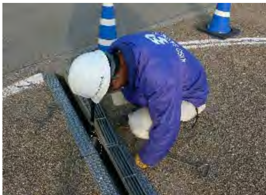
駐車場の排水溝や園内施設の裏面等の点検調査状況
