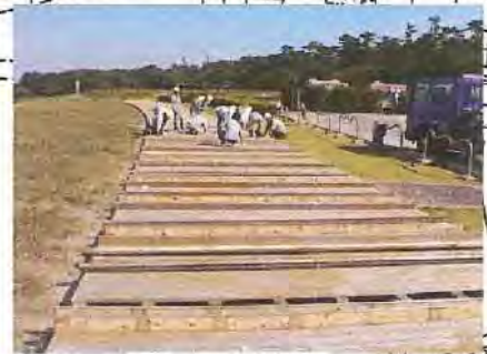
①デッキ撤去
