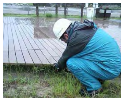
ワイルドネイチャープラザ河畔デッキ
