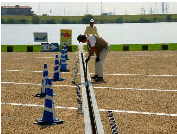
東海広場での詳細点検の状況
