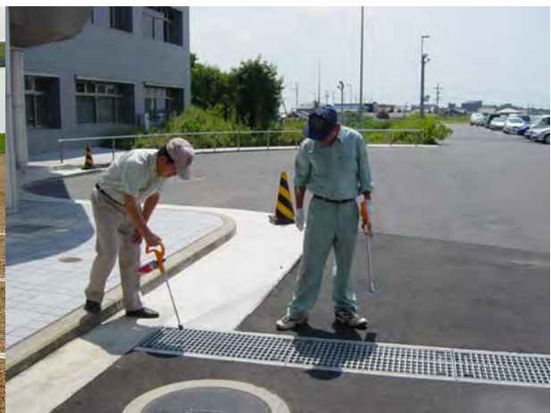
木曾川下流河川事務所での詳細点検の状況
