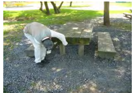
ワイルドネイチャープラザ 点検調査
