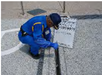
江南花卉園芸公園内 点検調査
