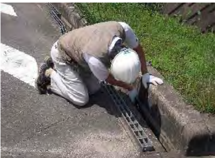
138タワーパーク側溝の点検調査
