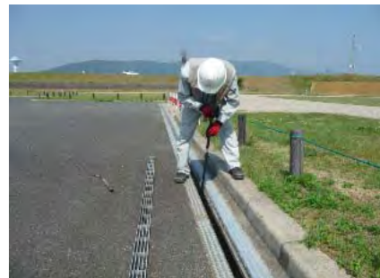
東海広場の駐車場の点検調査
