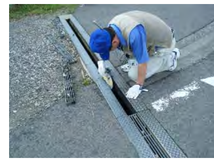
かさだ広場内 点検調査
