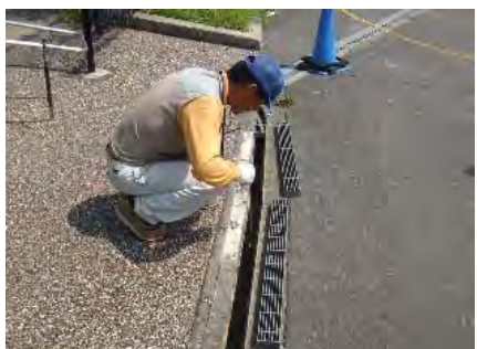
138タワーパーク側溝の点検調査
