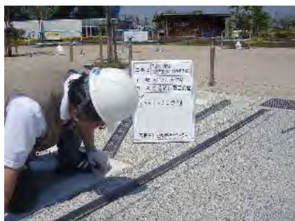
江南花卉園芸公園内 点検調査
