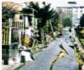
液状化現象による堤防被害の実例 (平成10年阪神・淡路大震災より)
