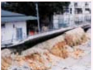
液状化現象による堤防被害の実例 (平成10年阪神・淡路大震災より)
