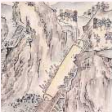
天保9年木曾大材井出小路伐出之図巻（名古屋博物館所蔵） 江戸城西の丸再建用の檜を伐り出したときの様子を描く。
