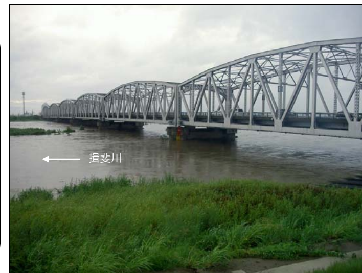
台風11号来襲による揖斐川の出水状況。(H26.8.10)
