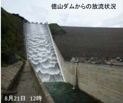
徳山ダムからの放流状況
