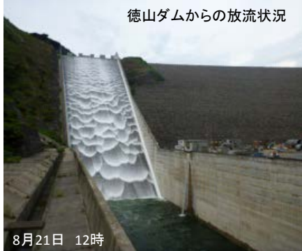
徳山ダムからの放流状況
