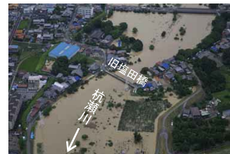
平成20年9月洪水 (杭瀬川右岸浸水状況)
