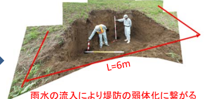
雨水の流入により堤防の弱体化に繋がる恐れがあるため、応急的に補修を実施。
