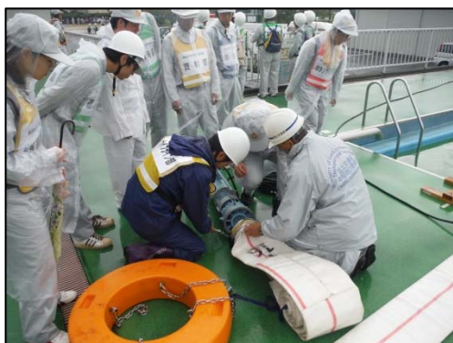
輪之内町職員による排水ポンプ車の設置訓練
