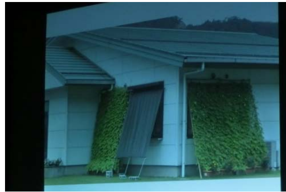
グリーンカーテンによる室内温度抑制実験の様子 (株)りゅういき
