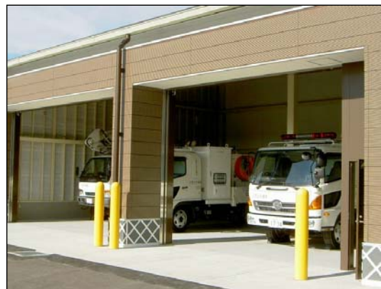
排水ポンプ車（2台配置）、照明車（1台配置）
