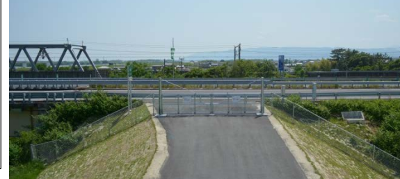
平成30年3月に完成した緊急開口部
