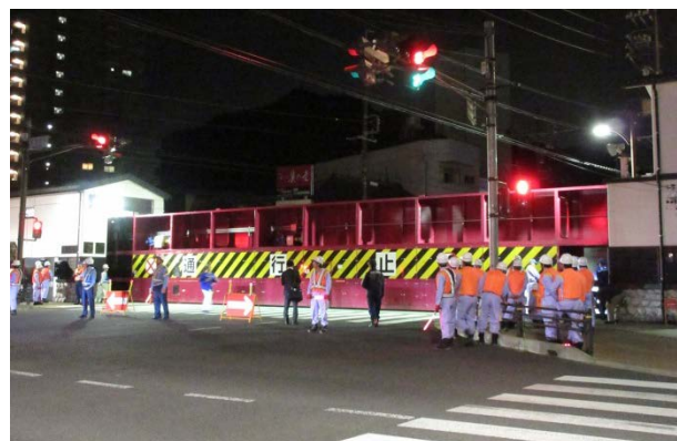
【長良・大宮陸閘整備点検操作訓練】
