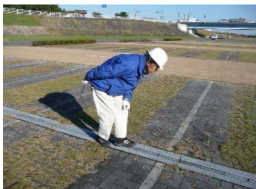
木曾三川公園センターの第1駐車場点検調査
