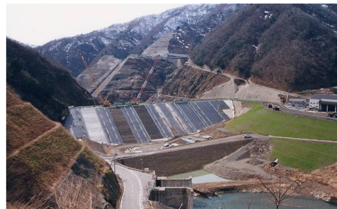
【事例①】 掘削土砂を徳山ダム工事に有効利用 (コンクリート骨材や盛土材)
