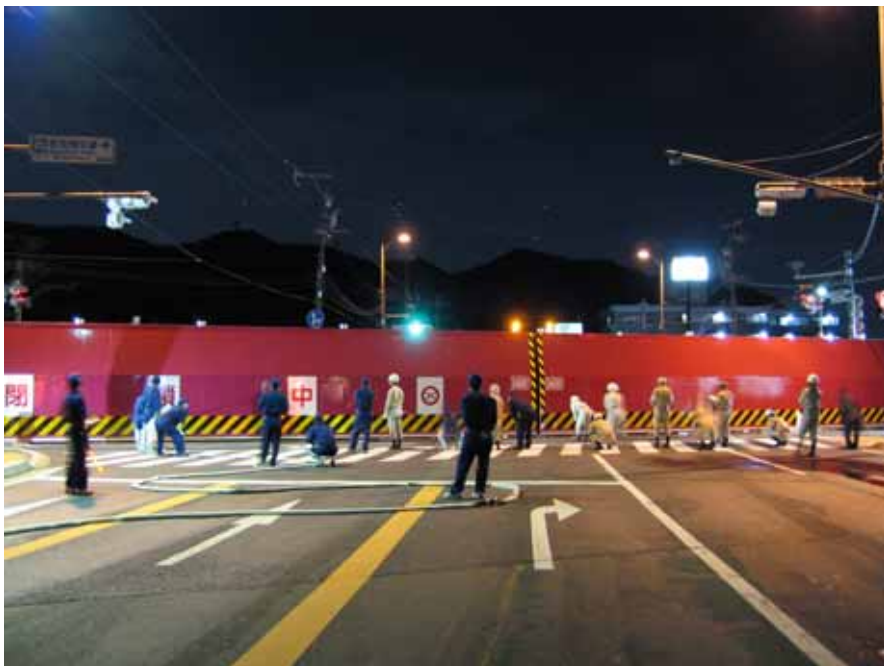
陸閘閉鎖状況
