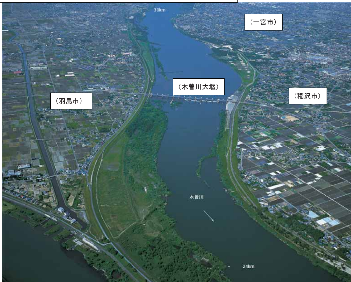
木曾川大堰周辺状況写真(木曾川24k-30k付近)
