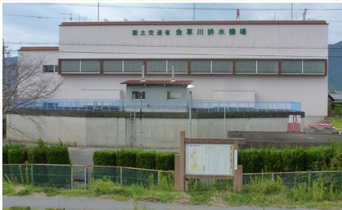
金草川排水機場
