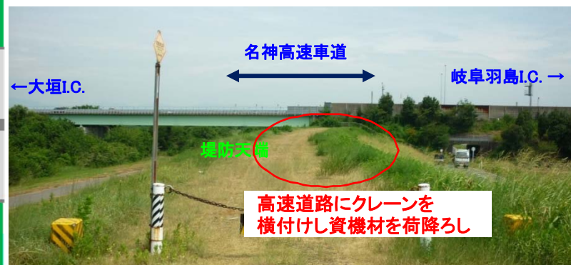
高速道路と堤防天端の交差部 (長良川左岸34.6k付近)
