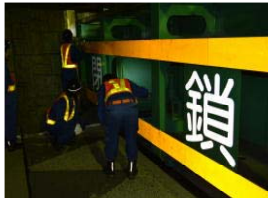
陸閘点検実施状況
