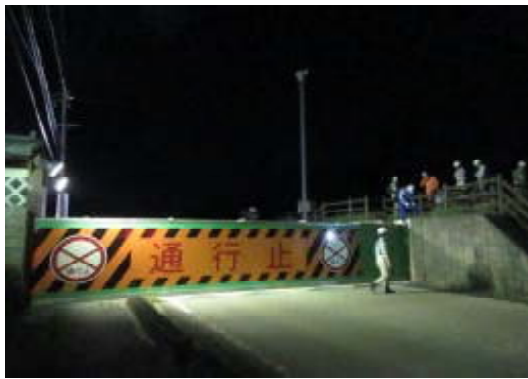
陸閘全景 通行止め実施状況 (鶴沼側より勝山陸閘を望む)
