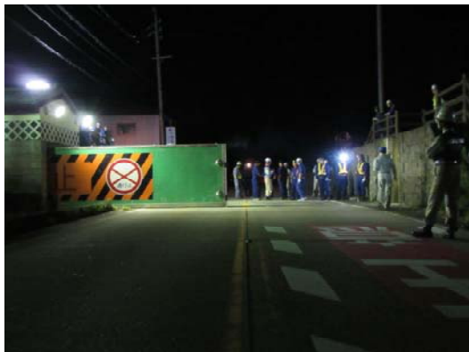
陸閘閉鎖作業状況
