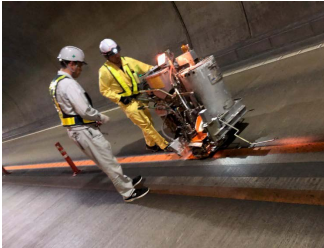
紀勢道(高丸山トンネル内) リブ付き区画線設置状況
