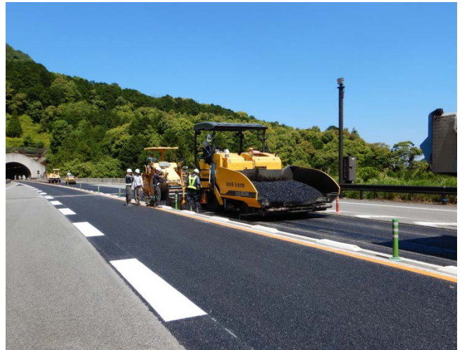
熊野尾鷲道路 舗装補修作業状況
