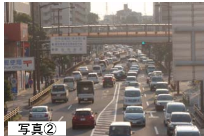
国道153号現道(挙母町交差点付近)
