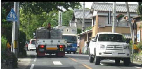
国道153号現道(越戸地区付近)
