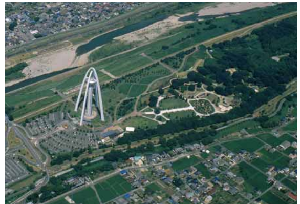
三派川地区の総合拠点「138タワーパーク」
