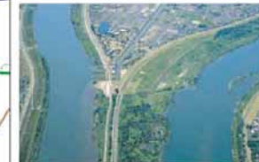
6 (仮称)桜堤サブセンター 岐阜県 羽島市
