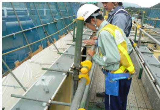
《橋工事現場見学》
