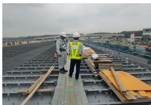
《東海環状自動車道工事現場見学》
