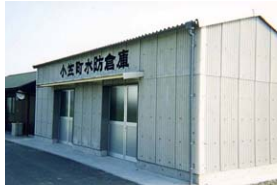
管理道路上に設置された水防倉庫
