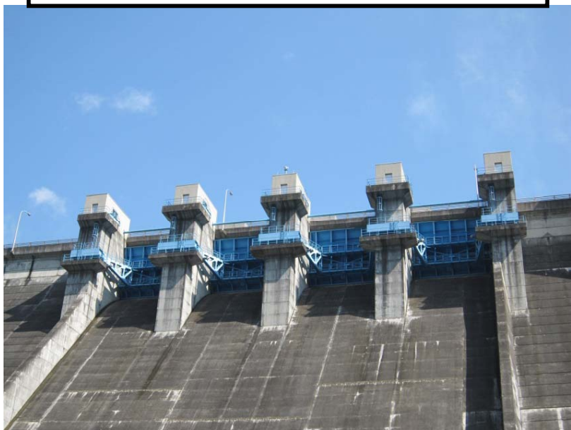
下流からの見上げた写真
