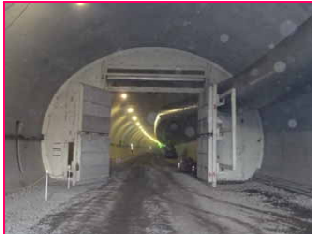
【岩田側坑口付近】
