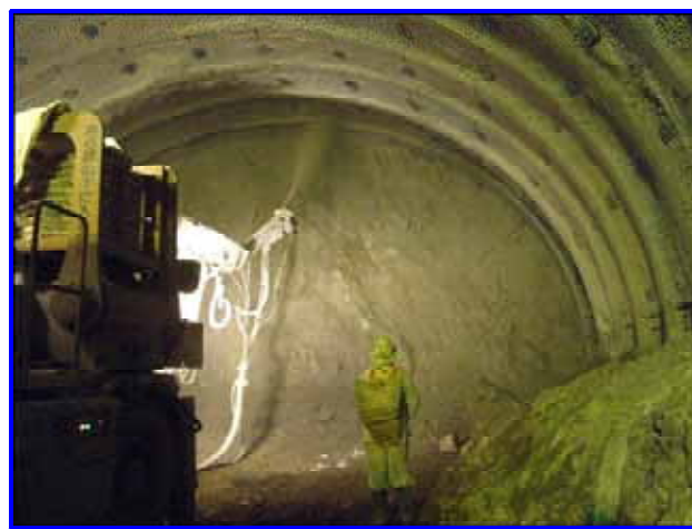
【トンネル坑内作業状況】
