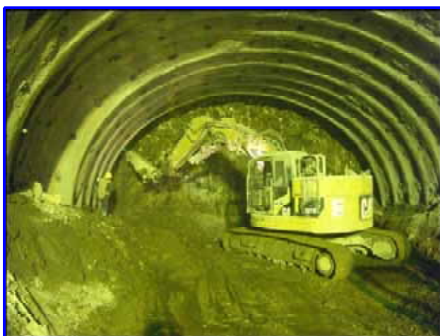
【トンネル坑内作業状況】
