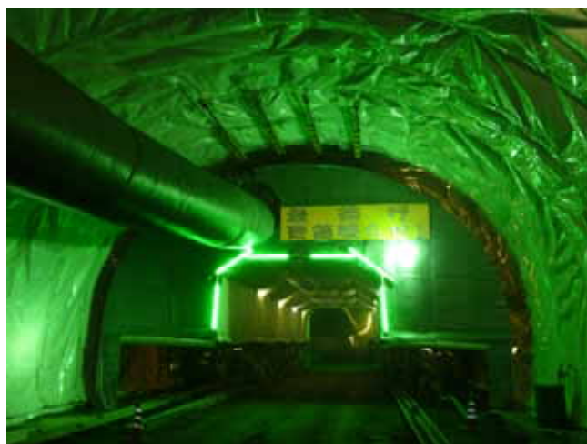
【岩田側坑口から710m】
