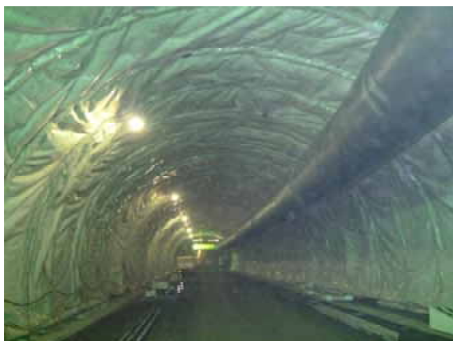
【岩田側坑口から710m】
