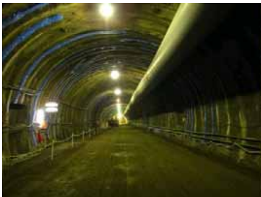
一般国道156号 岐阜東バイパス 岩田山トンネル工事
