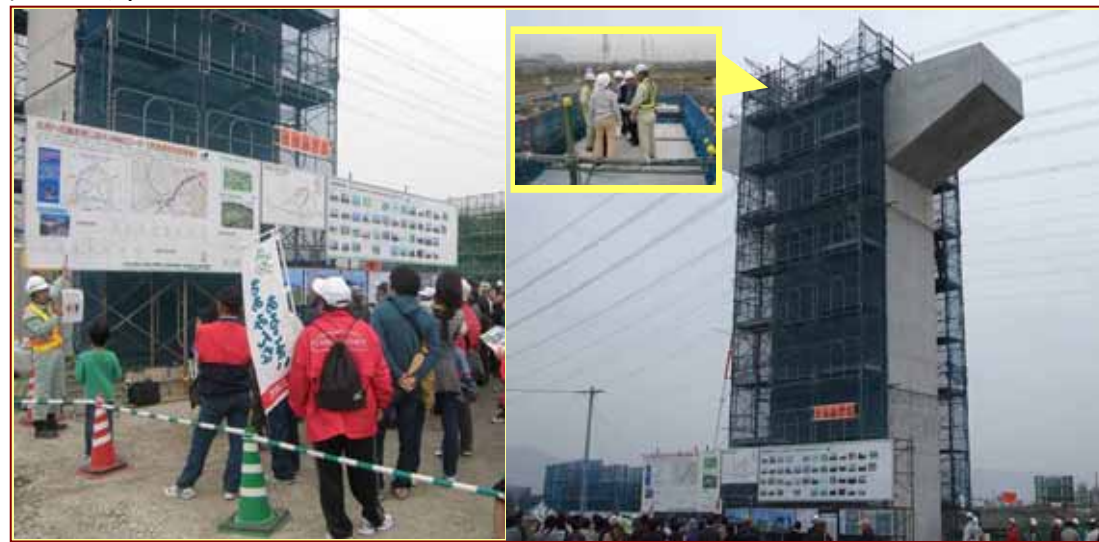
東海環状自動車道(西部区間)の(仮称)大垣西インターの橋脚工事現場で、実際に橋脚上部に登るなどして見学する大垣市民の皆さん(平成22年11月14日、大垣市西ブロックヘルシーウォークの一環で約250名が見学)
