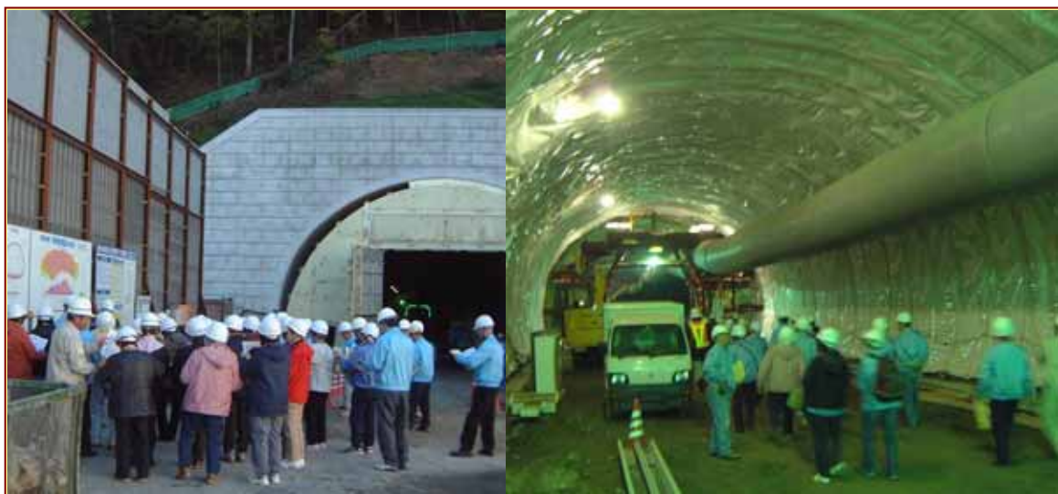
国道156号岐阜東バイパスのトンネル工事現場を見学する皆さん(平成22年11月19日、約40名参加)
