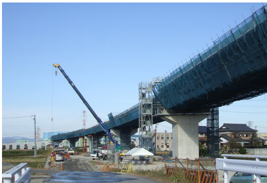
高架橋架設中の綾野地区(平成22年11月撮影)
