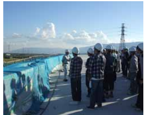
東海環状自動車道 大垣地区 工事中の高架橋上からの見学風景
