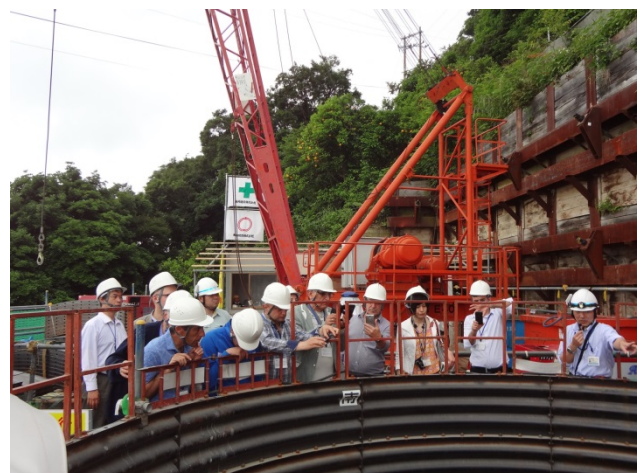
深礎杭工事の視察状況
