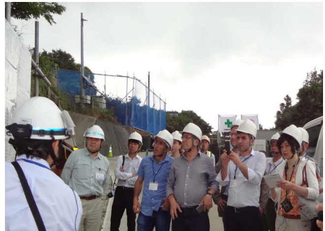
工事内容の説明状況
