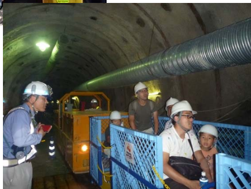
トロッコで 排水トンネルへ入坑
