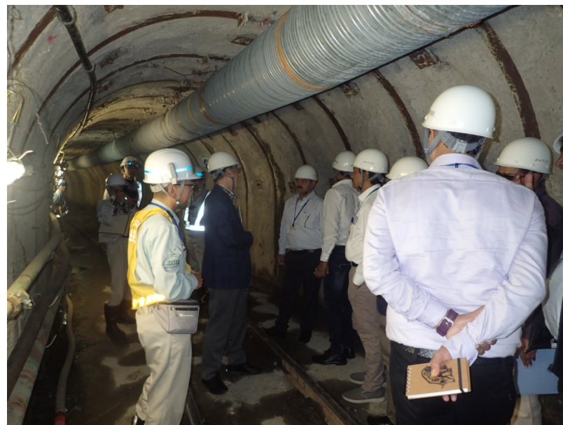
排水トンネル工事の視察状況
