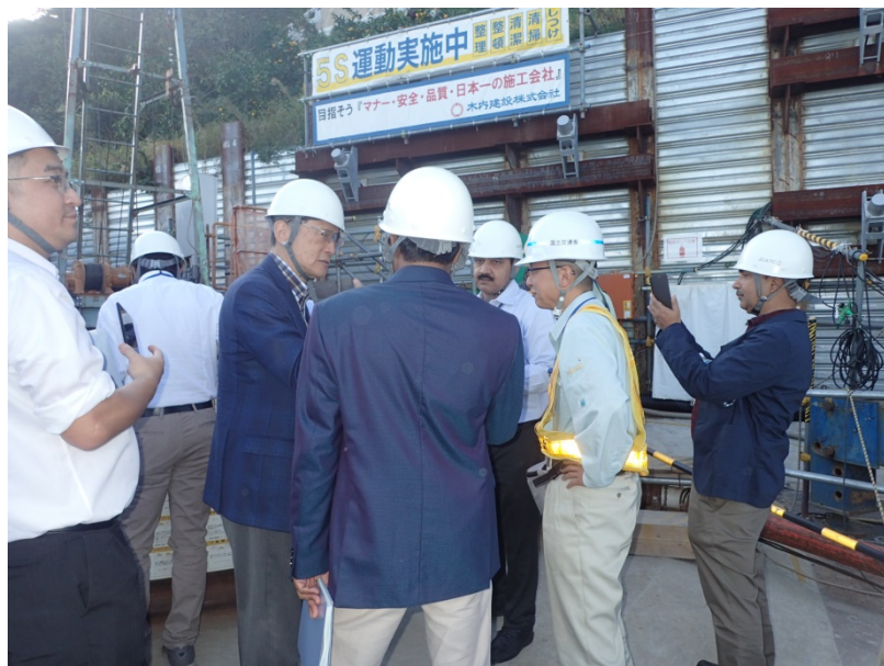
深礎杭工事の視察状況
