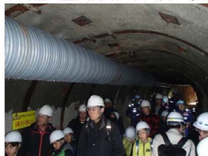
工事中のトンネル入坑
