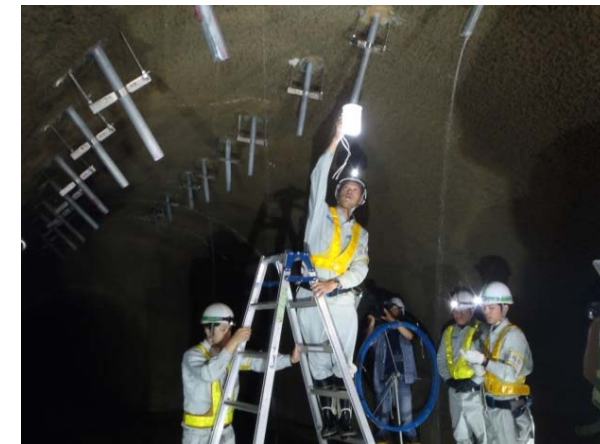
排水トンネル内で点検実施
