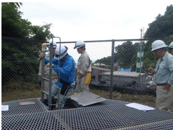
集水井点検のため井戸内へ移動
