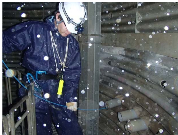
集水井内で点検実施
