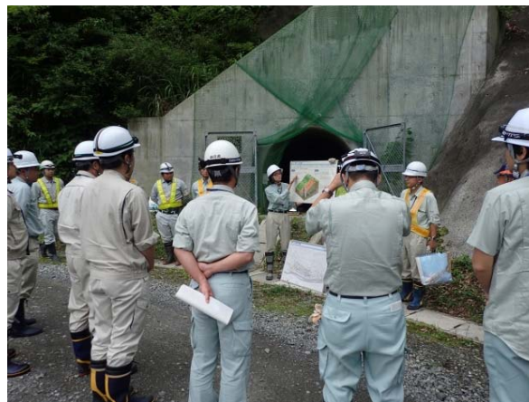
地すべり防止施設 概要説明
