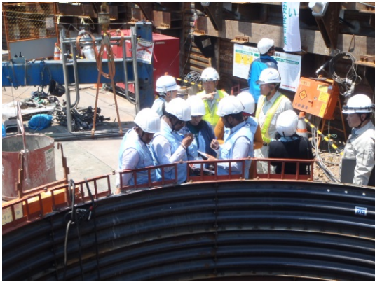
深礎杭施工状況の視察
