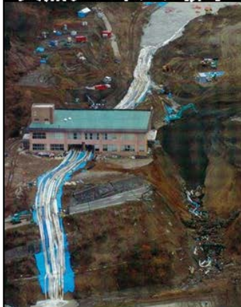
天然ダムポンプ排水
