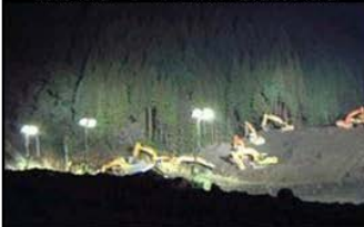
照明車による照明
