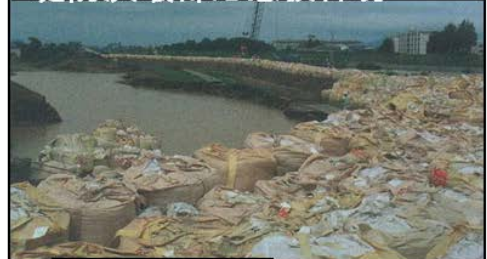
堤防決壊部応急仮締切
