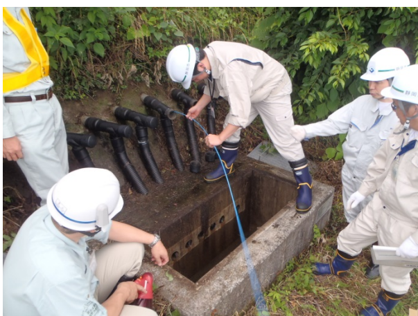
横ボーリングの点検状況
