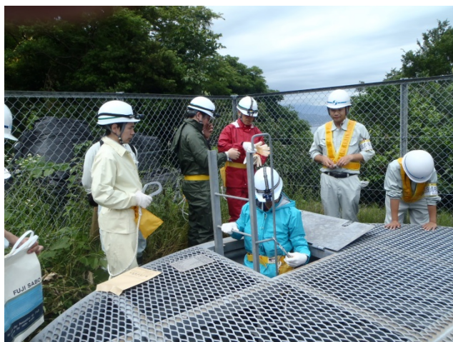
集水井の点検状況
