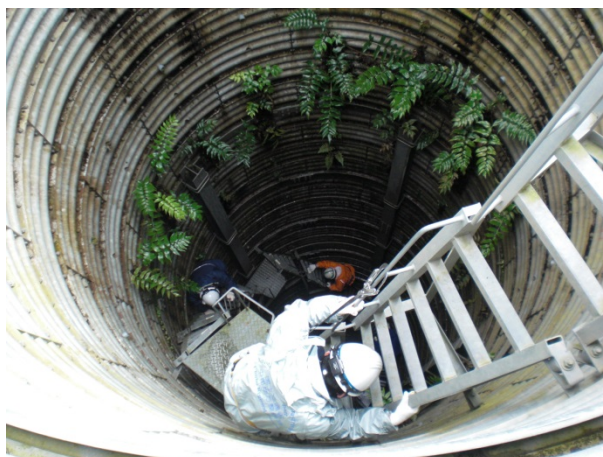
集水井の点検状況
