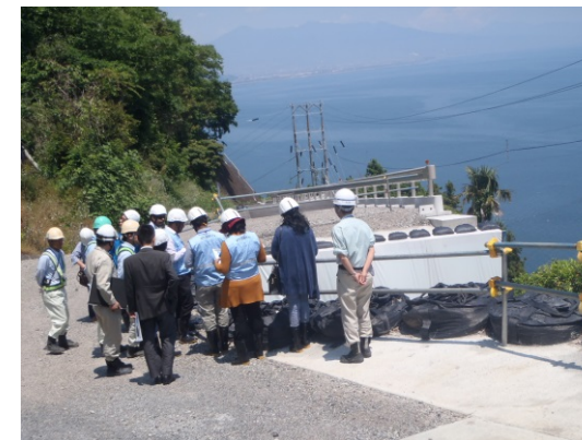
軽量盛土を使用した工事用道路の視察
