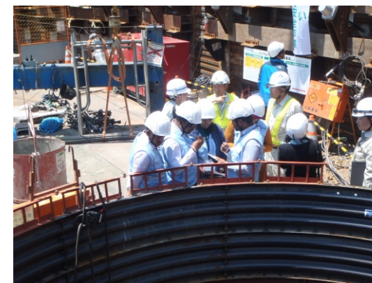
深礎杭施工状況の視察
