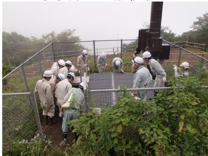
集水井工の点検状況
