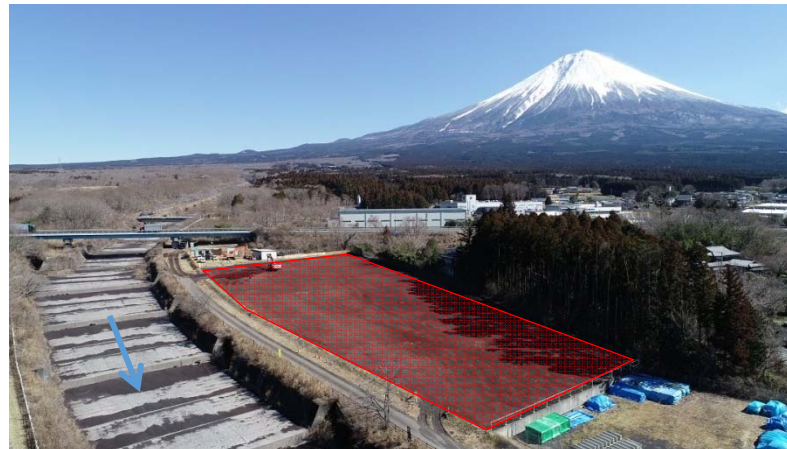
ブロック備蓄ヤードの整備状況 (富士宮市上井出)
