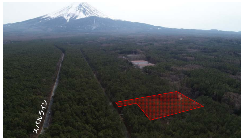
ブロック備蓄ヤードの整備予定地 (南都留郡富士河口湖町船津)
