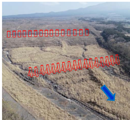
①第3床固め～第4上流床固め 流木対策施設を設置
