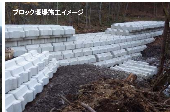
ブロック堰堤緊急施工事例 (御嶽山 ブロック堰堤)
