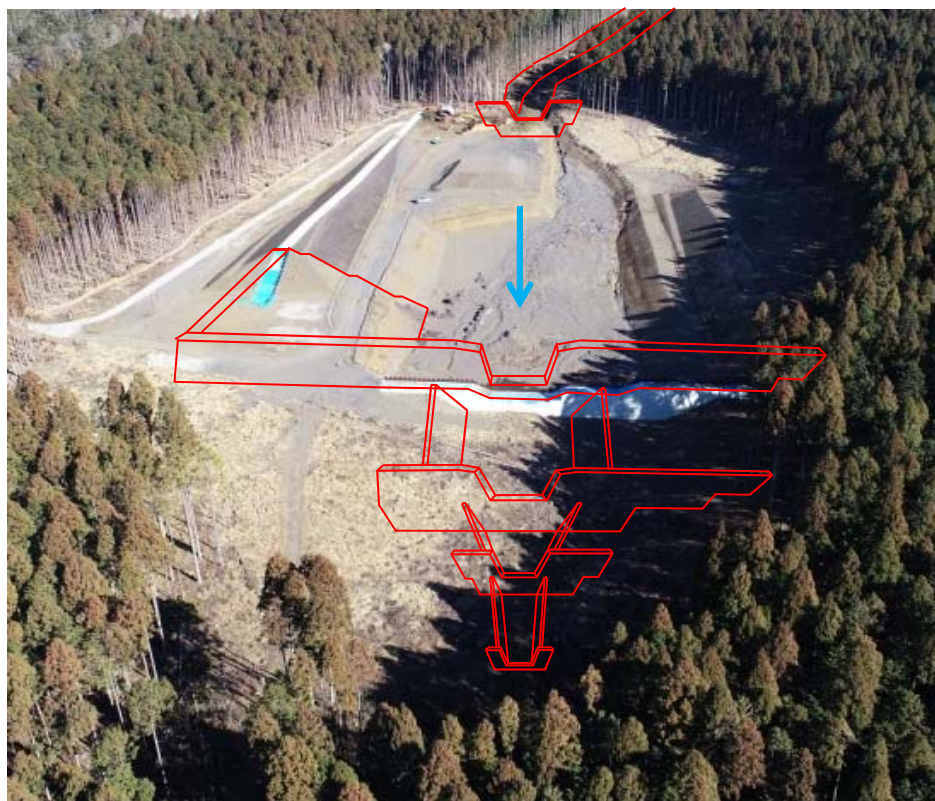
例) 鞍骨沢第1支溪遊砂地 (富士宮市北山地先)
