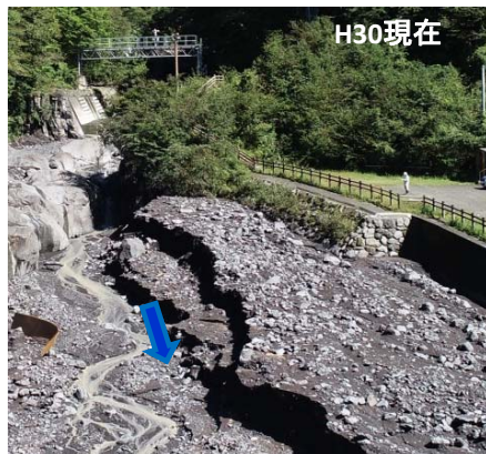
③岩樋付近 護岸天端付近まで堆積した土砂を撤去
