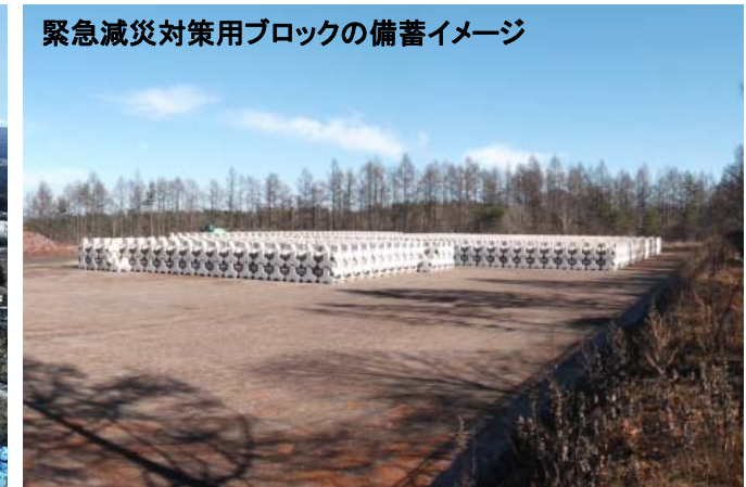
火山噴火緊急減災対策事例 (浅間山 砂原ストックヤード)
