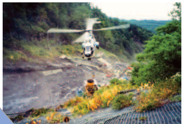
富士山源頭域調査工事
