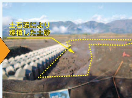
土石流発生後 第7上流床固工
