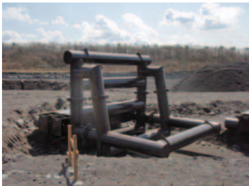
鋼製牛杵組立完了
