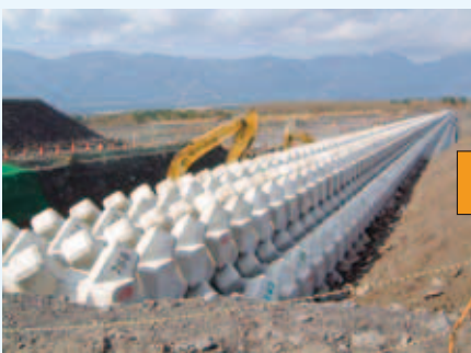
土石流発生前 第7上流床固工
