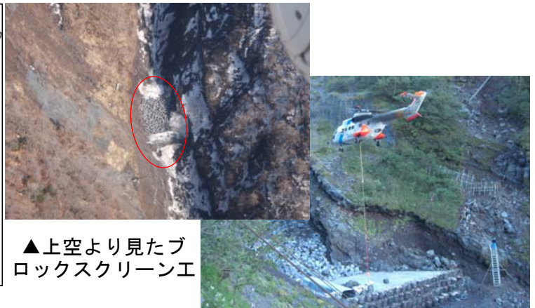
▲ヘリ施工により無人化施工
