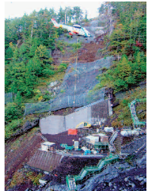
源頭域調査工事現場
