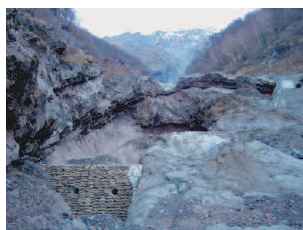
平成16年度施工の4の滝保護工
