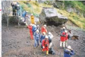
●源頭部調査工事現場
