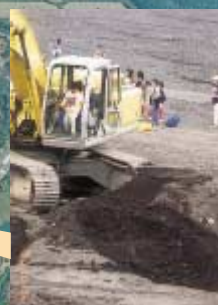
○ 重機のデモンストレーション
