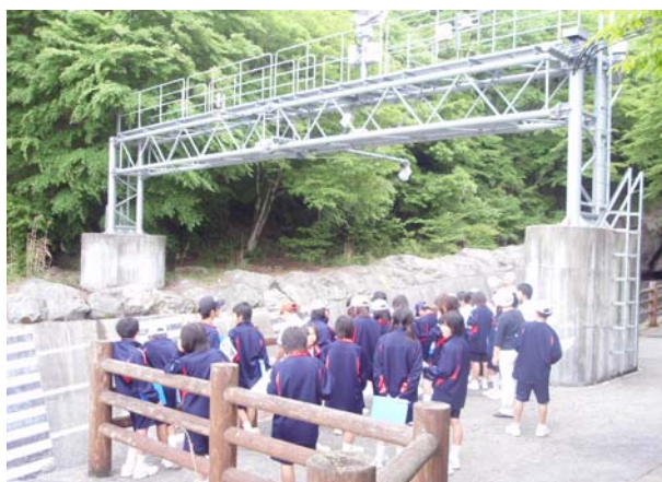
岩樋観測所下
