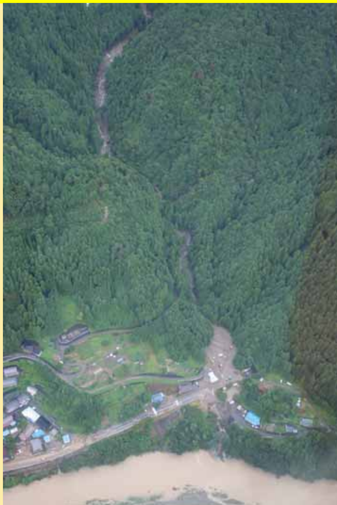
岐阜県揖斐川町東津汲の土砂災害
