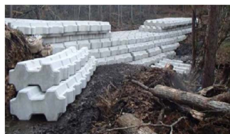
仮設堰堤の例(H26御嶽山)
